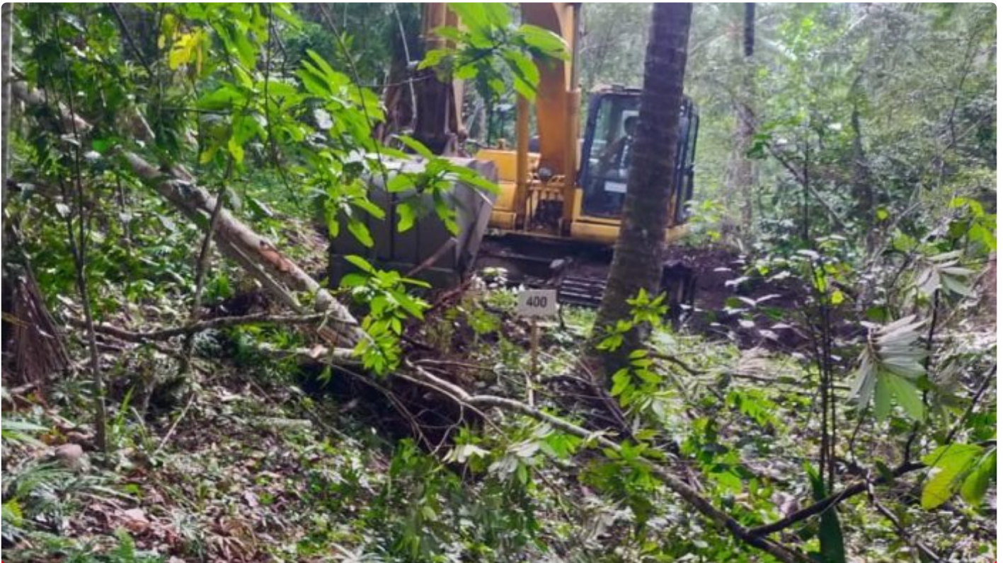
Pekerjaan akses Jalan TMMD Ke-116
